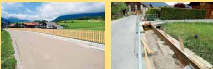
In vorbildlicher Zusammenarbeit mit der Wildbach- und Lawinerverbauung konnte das Ufermauerwerk bis zur Gewässersohle saniert und mit einem Schrammbord von ca. 15 cm erhöht sowie ein Holzzaun als Absturzsicherung errichtet werden, der den Sicherheitsanforderungen entspricht. Um die Verkehrssicherheit zu erhöhen wurden neue LED-Straßenlampen entlang des Krebsbaches aufgestellt.
