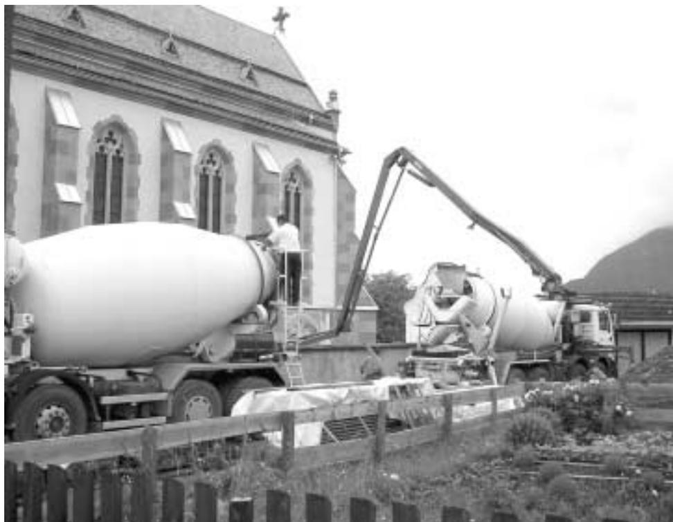
*70 m<sup>3</sup> Fertigbeton für den Estrich*
