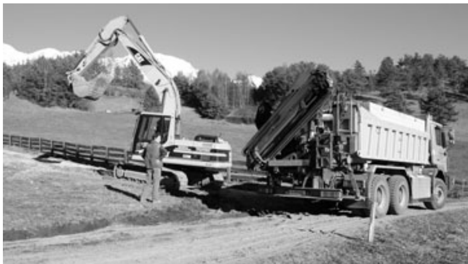
Zügig voran schreiten die Arbeiten zum Ausbau des Kanalnetzes zwischen dem Weiler Krebsbach und dem Regenüberlaufbecken in Untermieming
