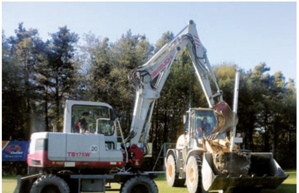
Erst die beiden Bagger der Fa. Haselwanter aus Mieming konnten die alten Tore wegtransportieren.
