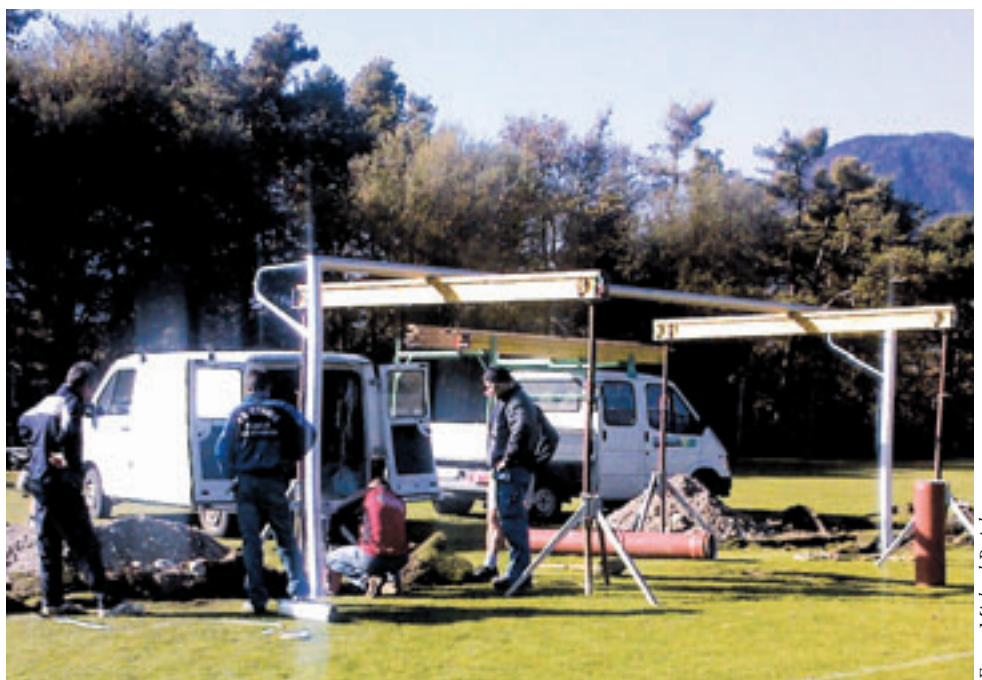
Unter fachmännischer Hilfe der Baufirma Grutsch Bau Obsteig werden die neuen Tore exakt eingemessen.
