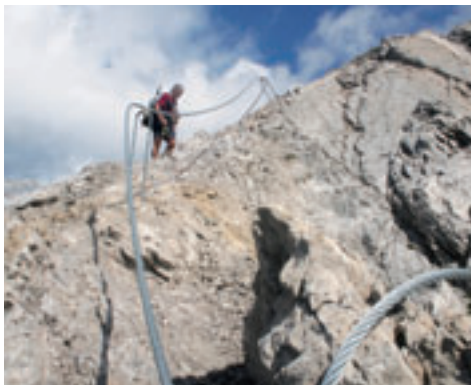
Obmann des Sport- und Kletterklubs Mieming Martin Ruech bei den Sanierungsarbeiten
