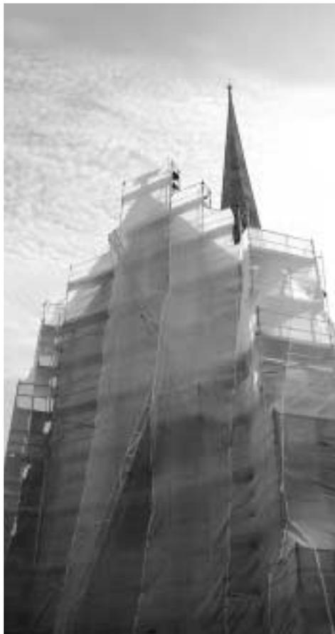
*Nach Abschluss der Blecharbeiten durch die Firma Moll aus Vorarlberg sind nun die Restauratoren der Firma Öffner aus Polling dabei, die Verputz- und Mauerschäden an der Außenfassade des Kirchenschiffes auszubessern.*
